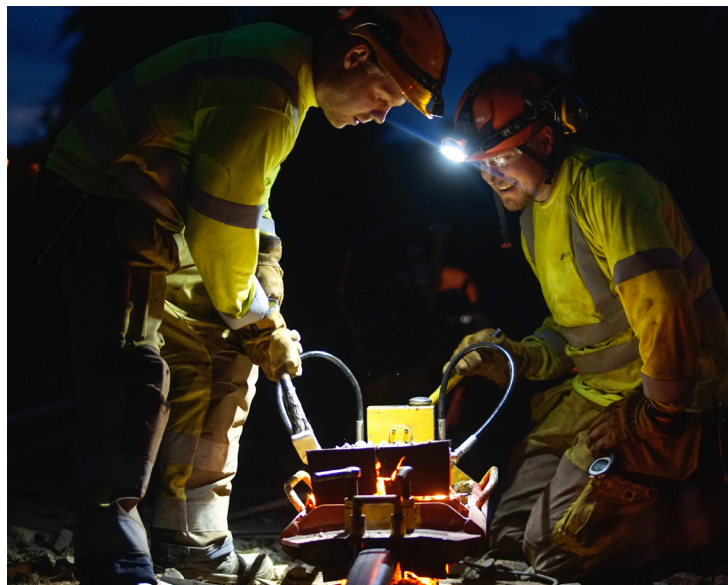
■ Rasmus Schultzberg och Louis Burgi svetsar och underhåller järnvägen – mitt i natten.
