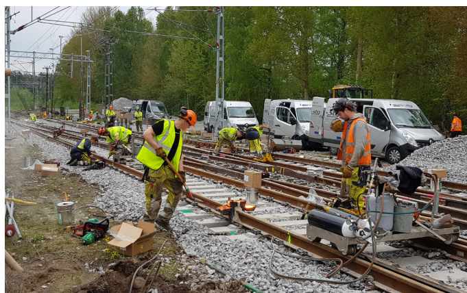
■ Här, vid Åby driftsplats, läggs Sveriges största spårkryss.
